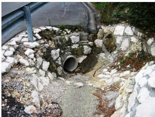
Slika 6 Vtok v prepust
