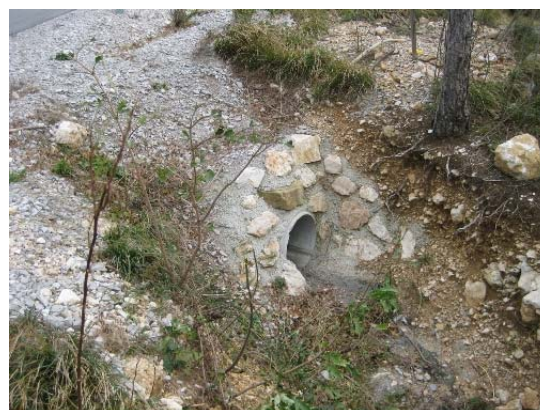
Slika 3 Iztok iz cevnega prepusta DN600
